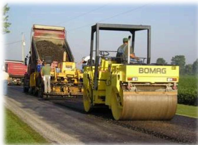
Рис. 11. Уплотнение холодной смеси Мультигрейд
