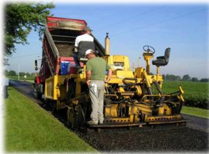
Рис. 10 Укладка холодной смеси Мультигрейд
