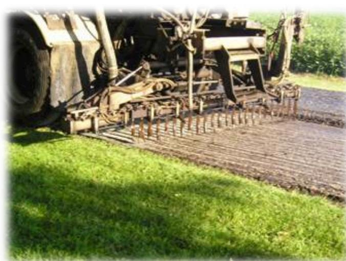
Рис. 9. Подгрунтовка битумной эмульсией
